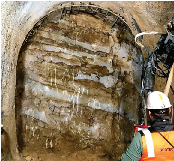
Abbildung 4-1: Einvernehmliche ingenieurgeologische Ortsbrustdokumentation im Rettungstollen.
