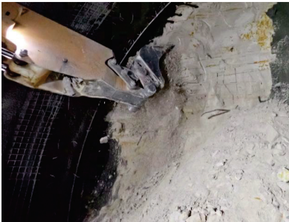
Abbildung 3-4: Mechanische Gebirgslösung mit Tunnelbagger LH 950 in der Kalotte des Haupttunnels.
