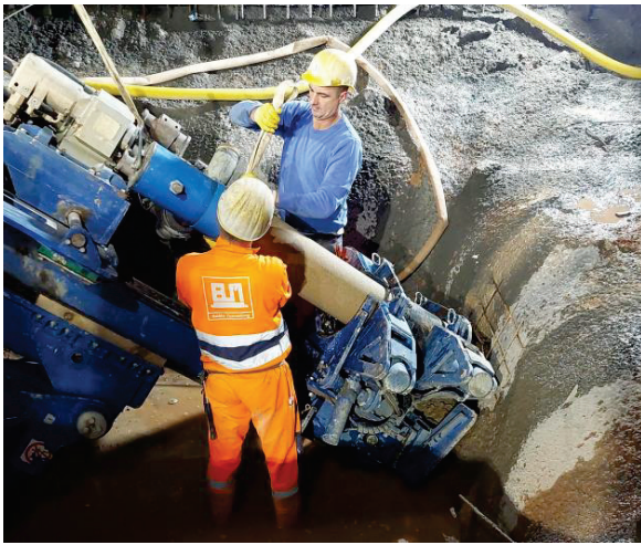
Abbildung 4-4: Verrohrte Vorausentwässerungsbohrung 12“ in der Kalottensohle des Haupttunnels.
