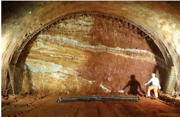
Abbildung 2-2: Buntsandsteinabfolge, die in der rechten Hälfte der Ortsbrust noch die primäre rote Farbe aufweist, während die linke Hälfte hydrothermal verändert, gebleicht und durch Eisenhydroxidausfällungen rostbraun verfärbt ist (Kalotte HT, TM 894,25).
