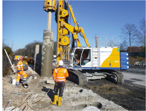
Abb. 3: Herstellung der Bohrpfehlwand (Foto: ARGE Geotechnik B51).
