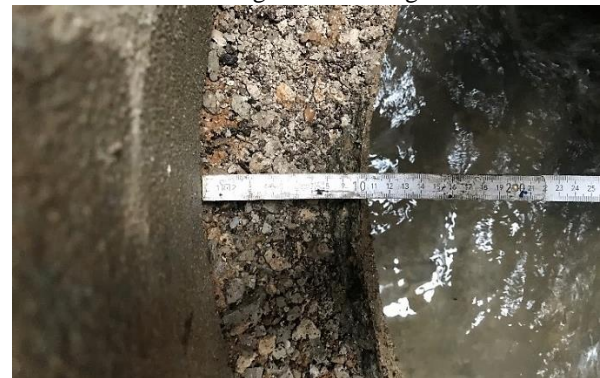
Abb. 7: Deformation in einem Entwässerungsschacht (Foto: BBB).
