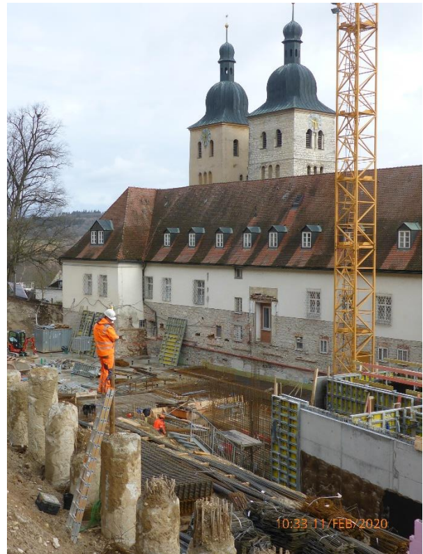
Abb. 12: Ausbau der Inklinometerkette aus der Bohrpfahlwand nach Beendigung der Überwachung im Februar 2020. Die batteriebetriebene Datenerfassung befindet sich in dem schwarzen Messkoffer am Fuß der Messstelle (Foto: Dr. Singer).
