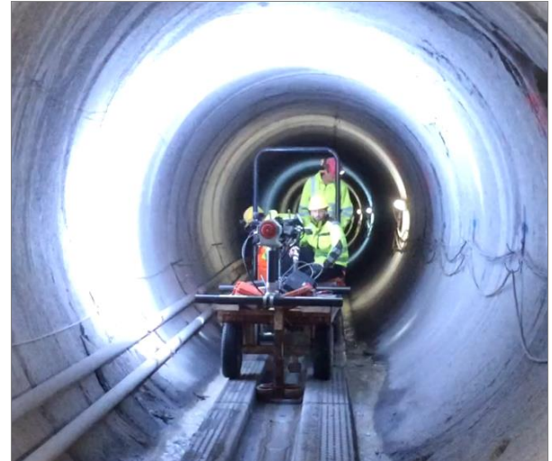
Abb. 9: 3D-Aufnahme durch das hybride Aufnahmesystem. Vorne befindet sich der Linienscanner, dahinter anschließend Digitalkameras, die die Tunnelleibung fotografieren. Der helle Lichtsaum wird durch den Blitz einer Kamera hervorgerufen (Foto: Dibit).
