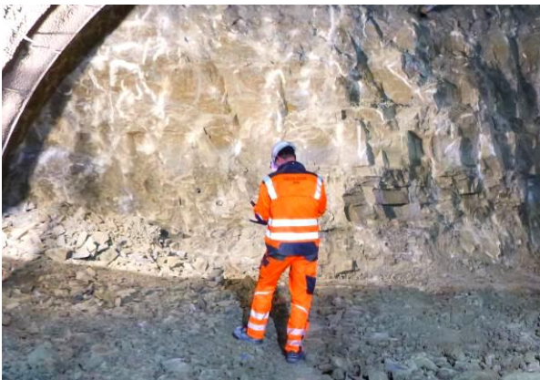
Abb. 1: Ortsbrustaufnahme im konventionellen Tunnelbau: „Standardfall“ der ingenieurgeologischen Dokumentation (Foto: Dr. Plinninger Geotechnik).
