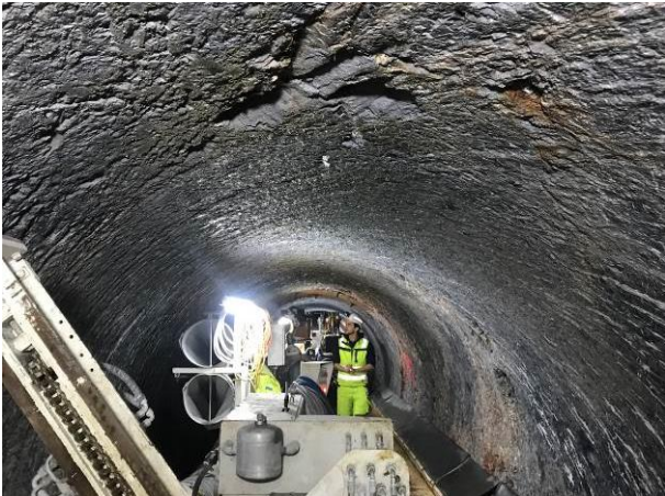
Abb. 5: AG-Geologe im vorderen Arbeitsbereich der TBM bei der Feldaufnahme, Blick gegen die Vortriebsrichtung (Foto: Pöyry/geo.zt).
