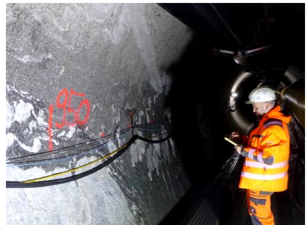
Abb. 7: AN-Geologe hinter dem Nachläufer der TBM bei der Feldaufnahme, Blick in Vortriebsrichtung (Foto: Dr. Plinninger Geotechnik).
