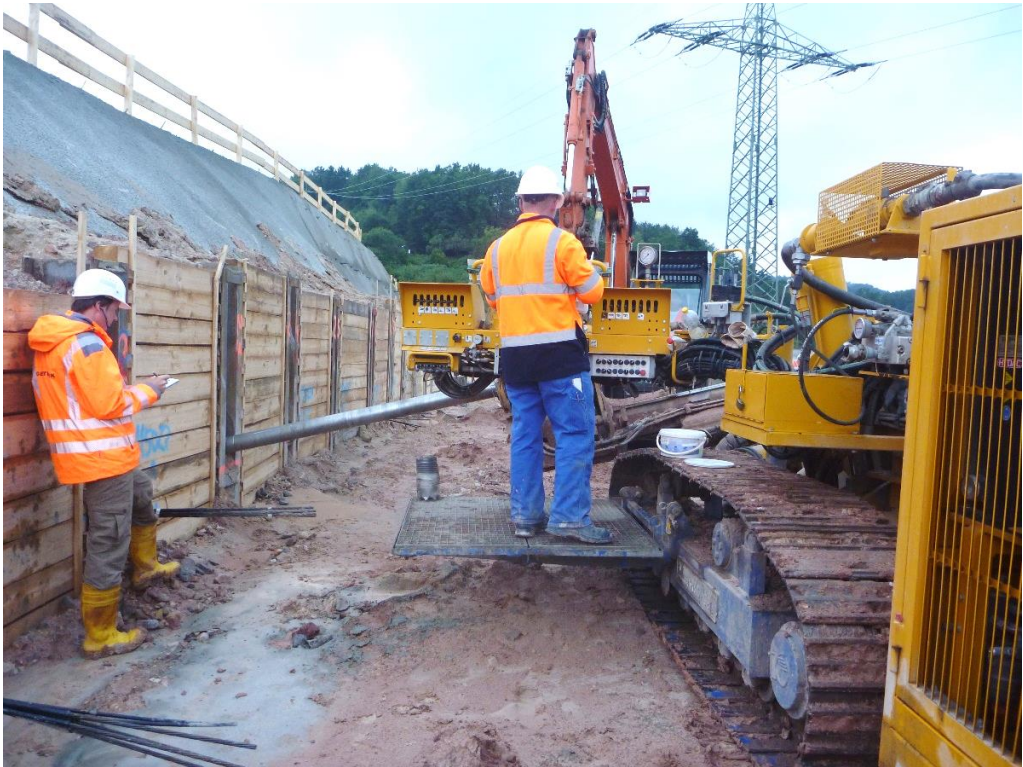
Abb. 6 Baubegleitende ingenieurgeologische Feldarbeit im Spezialtiefbau, hier die Dokumentation einer Ankerbohrung.
