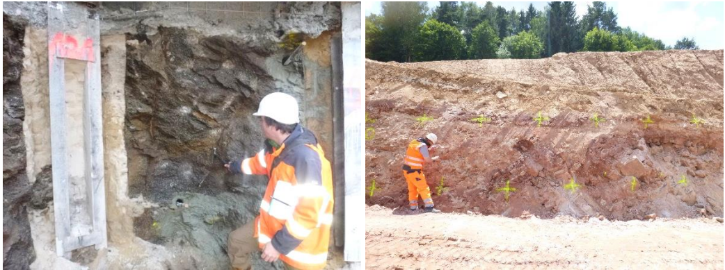
Abb. 7 Direkte geologische Dokumentation des freiliegenden Gebirges im Zuge laufender Aushubarbeiten: Links: Offene „Fächer“ zwischen Trägerbohlbohrungen. Rechts: Freigeböschte Einschnittsböschung im Buntsandstein.
