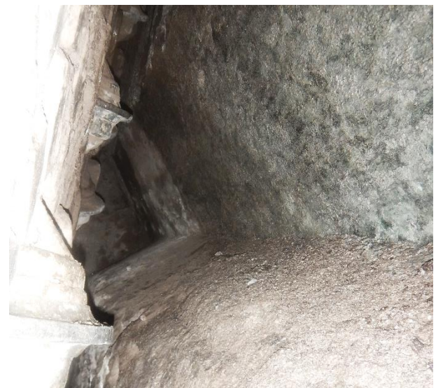
Bild 3: Keilförmiger, an Schieferung und Klüftung gebundener Ausbruch vor dem Bohrkopf einer Hartgesteins-TBM – eine „Mixed Face Condition“ als Folge von „Blockigkeit“ (Foto: Plinninger / AGTK.2).
