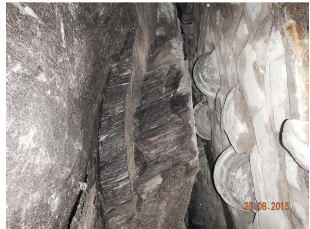
Bild 6: Typische Ausbildung spannungsinduzierter Abplatzungen im TBM-Vortrieb: Listrisch gebogene, vom Trennflächengefüge weitgehend unabhängige Gesteins-scheiben an der Ortsbrust eines TBM-Vortriebs: (Foto: Plinninger/AGTK.2).
