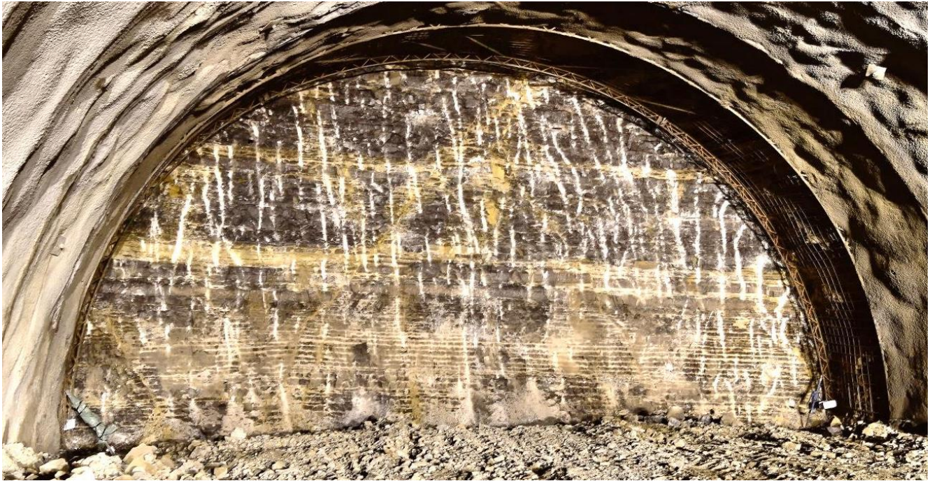
Bild 3: Typische Ausbildung des Gebirges in den Nodosus-Schichten mit dunkelgrauen, unverwitterten Kalksteinlagen sowie hellgrau bis bräunlichen, mergeligen Zwischenlagen im Haupttunnel des Tunnels Darmsheim, hier TM 147,50 am 14.09.2015.
