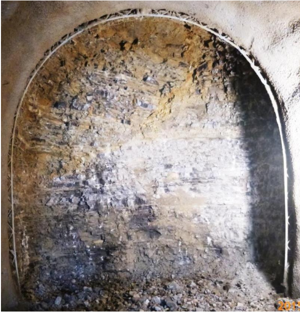
Bild 6: Karststruktur im Rettungstollen, TM 23,0 am 07.07.2015: Während die Muschelkalkfolge in der rechten unteren Hälfte der Ortsbrust eine regelmäßige, sölige Lagerung zeigt, weist sie in linker Ulme, Kämpfer und Firste ein flaches Einfallen nach rechts auf, mit einer deutlichen „Winkeldiskordanz“ an einer verwitterten und verlehnten, mittelsteil nach Links einfallenden Diagonalkluft.
