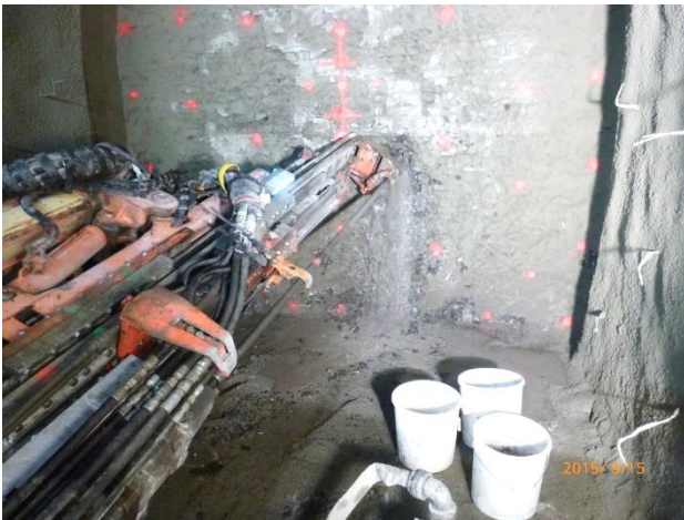
Bild 9: Beispiel für eine Vorauserkundungsbohrung mit Vortriebsbohrausrüstung im Rettungstollen.
