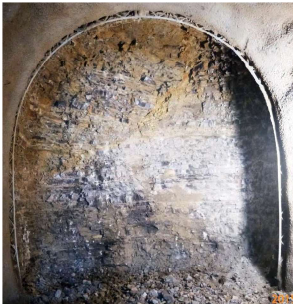
Abbildung 3-2: Karsterscheinungen im Rettungstollen, TM 23,0 am 07.07.2015: Während die Muschelkalkfolge in der rechten unteren Hälfte der Ortsbrust eine regelmäßige, sölhlige Lagerung zeigt, weist sie in linker Ulme, Kämpfer und Firste ein flaches Einfallen nach rechts auf, mit einer deutlichen „Winkeldiskordanz“ an einer verwitterten und verlehnten, mittelsteil nach Links einfallenden Diagonalkluft.
