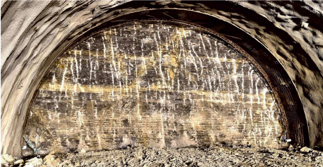
Abbildung 2-1: Typische Ausbildung des Gebirges in den Nodosus-Schichten mit dunkelgrauen, unverwitterten Kalksteinlagen sowie hellgrau bis bräunlichen, mergeligen Zwischenlagen im Haupttunnel des Tunnels Darmsheim, hier TM 147,50 am 14.09.2015.
