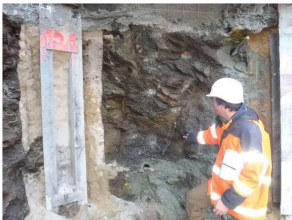
Abbildung 4: Direkte geologische Dokumentation des freiliegenden Gebirges im Zuge der laufenden Aushubarbeiten.
