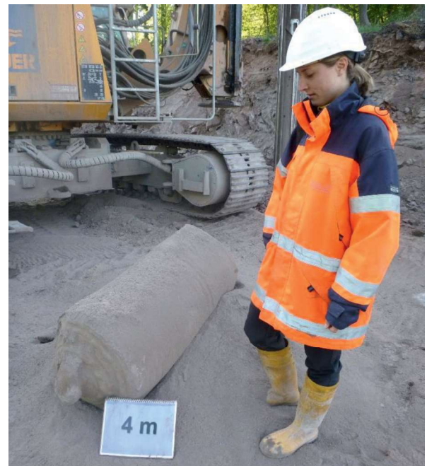
Abbildung 5: Kerngewinn im frischen Diorit mithilfe des Kernbohrrohrs.
