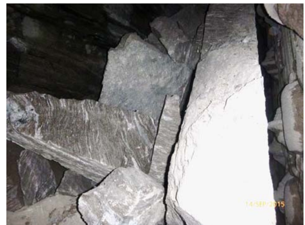
Bild 7: Kubikdezimeter bis Kubikmeter-große, aus der Ortsbrust ausgebrochene Gneisblöcke vor dem Bohrkopf einer Hartgesteins-TVM. Disken und Bohrkopf sind an der rechten Bildkante erkennbar.
