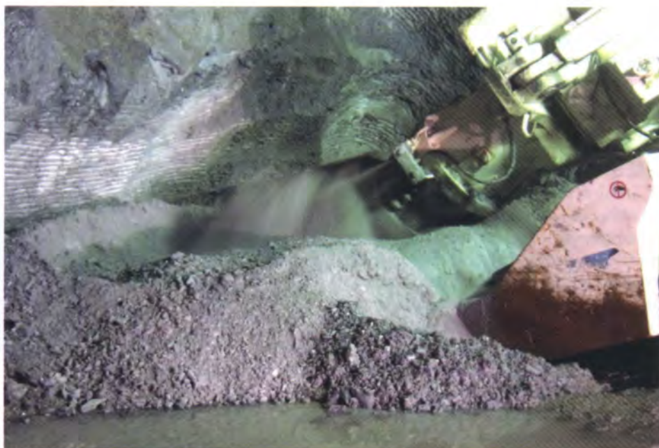
Fig. 15 – Avanzamento con fresa puntale pesante nella fillade quarzifera. A causa della ridotta fatturazione dell'ammasso sono chiaramente riconoscibili le tracce lasciate da ogni picco sul fronte (foto: Plinninger).
