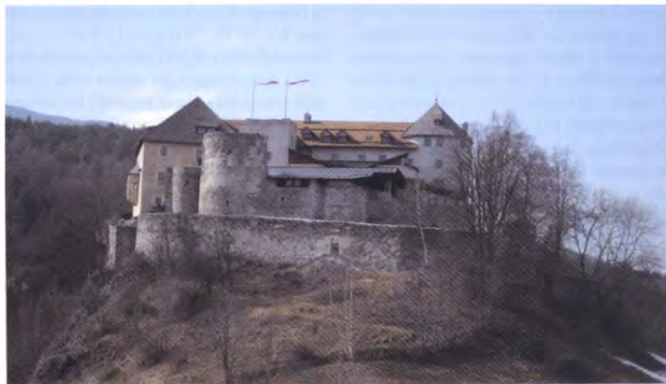
Fig. 12 – Fortificazione Castel Badia, vista dal portale est in asse alla galleria (Foto: Plinninger).
