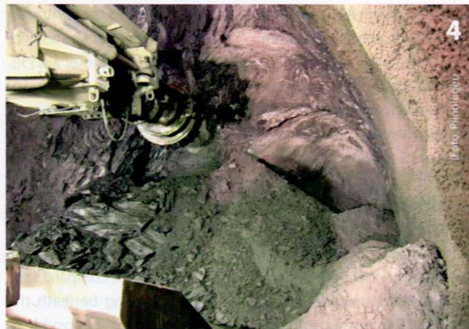
Ausbruch mit der TSM in Quarzphylliten. Durch die geringe Zerlegung des Gesteins sind die Schneidspuren jedes Meißels an der Ortsbrust deutlich erkennbar. Roadheader excavation in quartz phyllite. The cutting lines of each bit are clearly discernible at the face on account of the low segmentation of the rock
