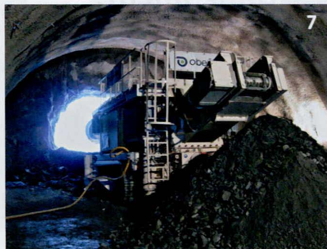
Durchschlag der TSM am Portal Amtmannbühl Roadheader breakthrough at the Amtmannbühl Tunnel
