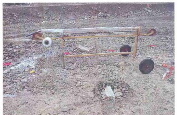
Bild 8. Vorbereitung des PVC-Folienschlauchs vor Einbringen in das Bohrloch
