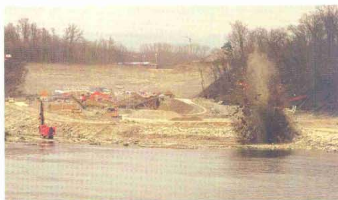
Bild 3. Sprengung in der Baugrube O [1] Fig. 3. Blasting in pit "O" [1]
