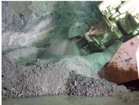
Bild 5: Ausbruch mit der schweren Teilschnittmaschine in Quarzphylliten. Durch die geringe Zerlegung des Gebirges sind die Schneidspuren jedes Meißels an der Ortsbrust deutlich erkennbar (Foto: Plinninger).
