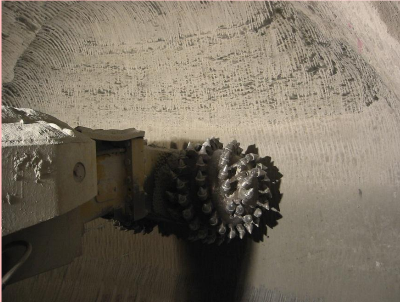
Profilgenauigkeit bei einem Vortrieb in Molassemergeln (Tunnel Tridel, Lausanne/CH, 2005)
