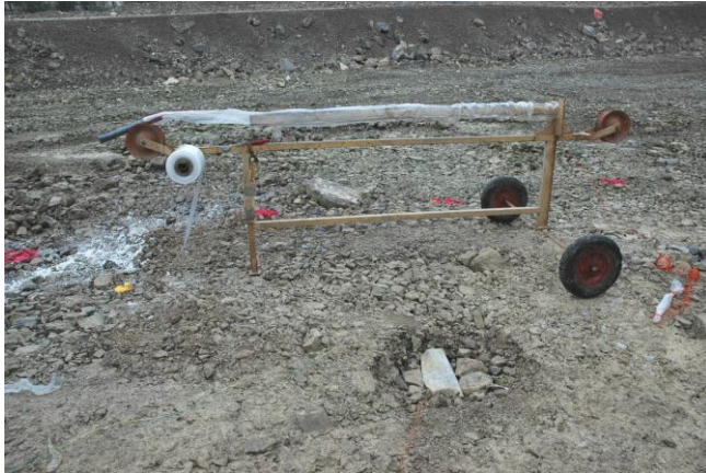
Abb. 8: Vorbereitung des PVC-Folienschlauchs vor Einbringen in das Bohrloch.
