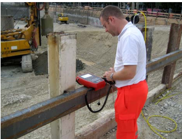
Bild 1: Inklinometermessung zur Überwachung einer Bohrpfahlwand bei einer tiefen innerstädtischen Baugrube (Foto: Dr. Plinninger Geotechnik).
