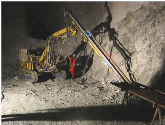
Abb. 7: Entnahme von orientierten Kernproben aus Gneiss mittels rechtwinklig zur Schieferung ausgerichtetem Einfachkernrohr (Pumpspeicherwerk Kops II/Österreich). Fig. 7: Core drilling, orientated exactly in a right angle to the foliation of gneiss in order to gain samples with defined orientation (Kops II power plant project/Austria).
