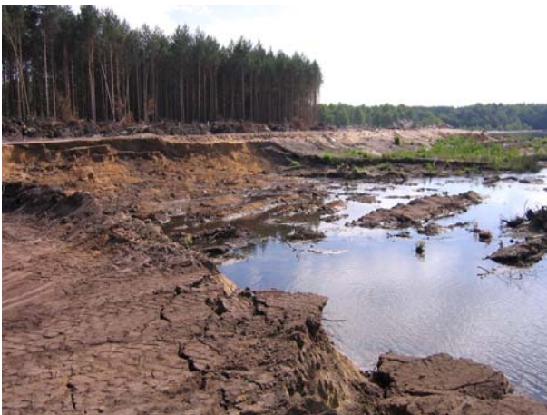
Bild 2: Rutschung im Vorfeld einer RDV, Höhe der Abrisskante ca. 4 m, davor sind staffelförmige Brucherscheinungen und die horizontale Ablagerung der Massen sichtbar. Der bereits verdichtete Damm links im Bild blieb erhalten.
