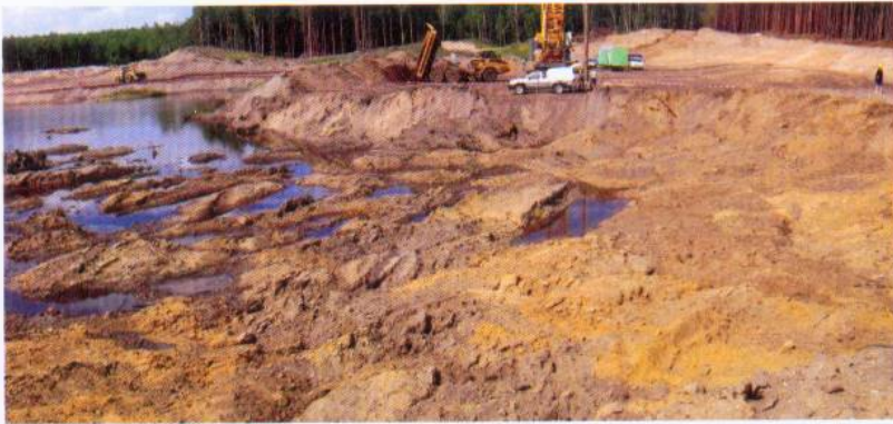
Bild 2 Setzungsfließversagen im Vorfeld einer Rütteldruckverdichtung. Höhe der Abrisskante etwa 4 m. Der bereits verdichtete Damm rechts im Bild blieb erhalten.
