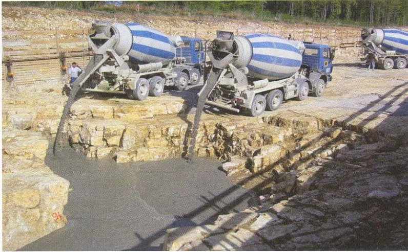
Bild 7 Betonverfüllung einer ausgedehnten, ursprünglich mit bindigem Lockergestein gefüllten Karststruktur im Einschnitt E7.
