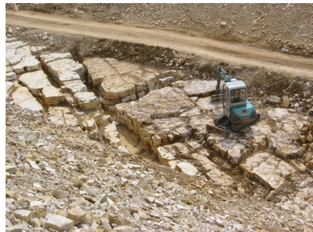
Abb. 11: Halbseitig freigelegte Einschnittsohle in bankigen Kalken mit ausgeräumten, bindig verfüllten Karststrukturen.
