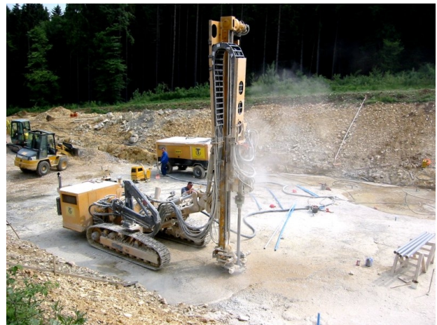
Abb. 14: Injektionsbohrgerät beim Abbohren eines 2,5 m-Injektionsrasters.
