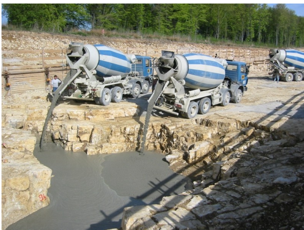
Abb. 13: Betonverfüllung einer ausgedehnten, ursprünglich mit bindigem Lockermaterial gefüllten Karststruktur.
